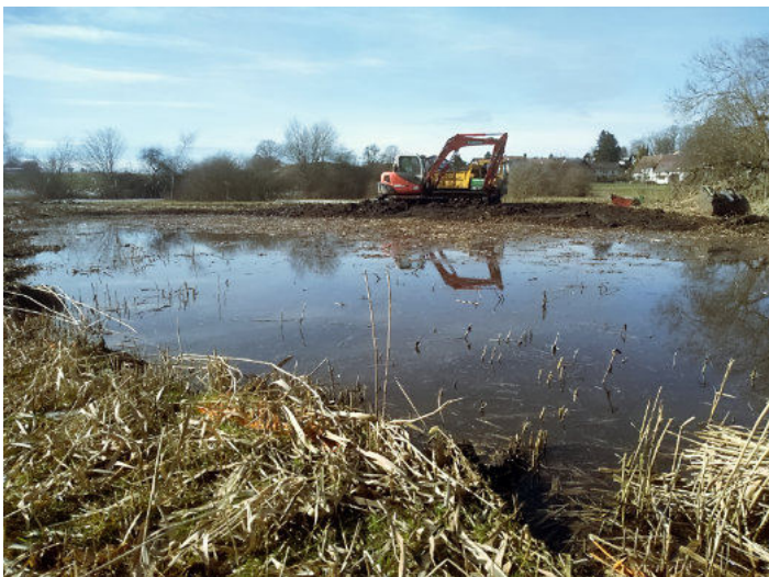
Baggerarbeiten zur teilweisen Wiedervernässung des Herrenweiher in Bergatreute
